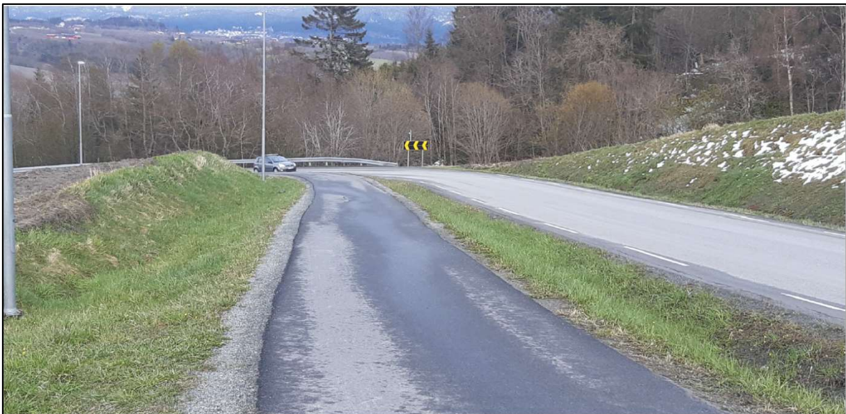
Figur 10 Utsikt i nordgående retning av Fv6644 fra planlagt adkomst til foreslått planområde.
