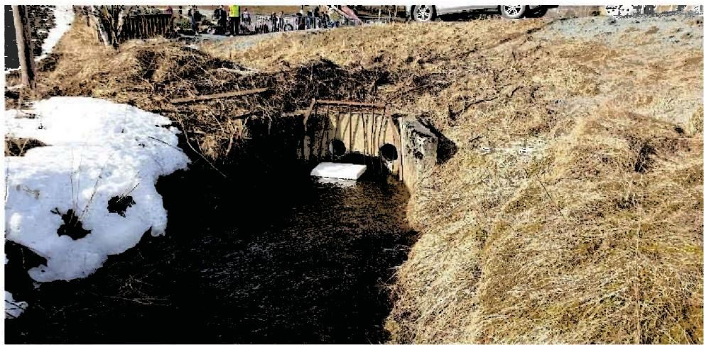
Figur 2 Innlop kulvert ved barnehagen. 1 stor ( $\varnothing=1\text{m}$ ) og 2 små ( $\varnothing=0.25\text{ m}$ ). Vst=110.45
