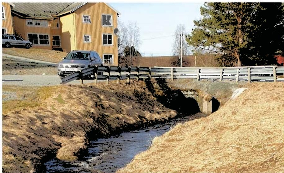
**Figur 8 Innløp kulvert ved Vennatunet. Diameter ca 1.2 m. Vannstand = 103.54 moh**
