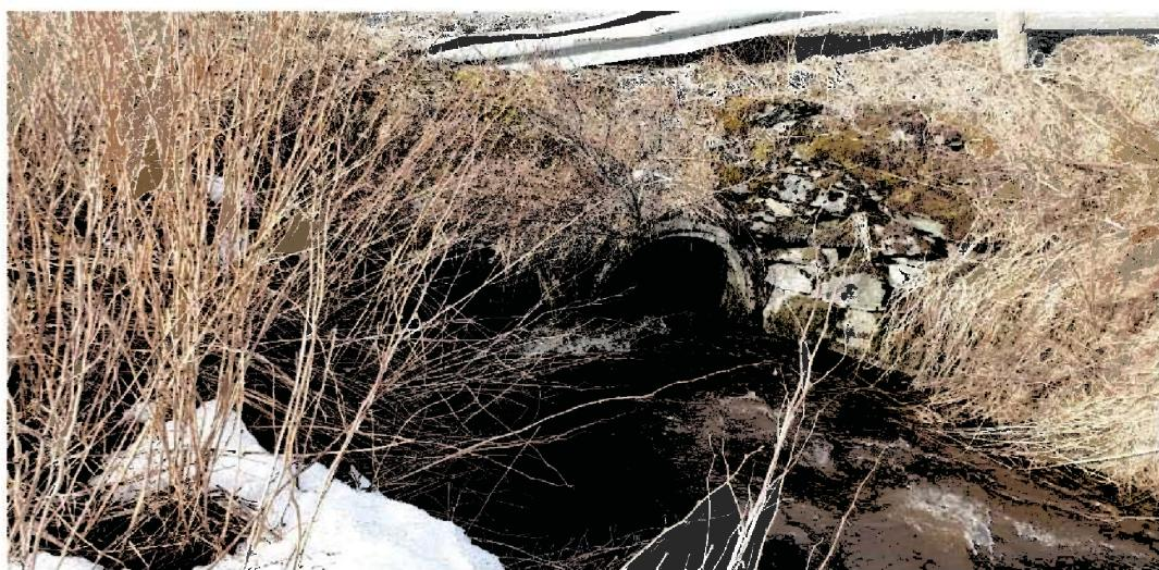
**Figur 6 Innløp kulverter under Syrstadgardanveien. Diameter ca. 1m. Vannstand = 107.92**
