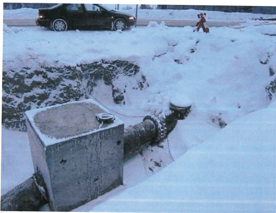
Bilde nr 28 (29.11.04): Forankringskloss ved pel 970.
